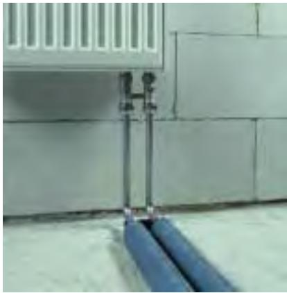
Σε γωνιακή σύνδεσης για τη σύνδεση του τελευταίου σώματος θέρμανσης
