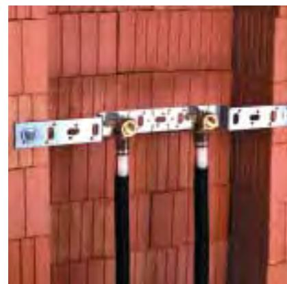
Παράδειγμα τοποθέτησης βάσης στήριξης για διπλή σύνδεση (πλατιά εγκοπή τοίχου)
