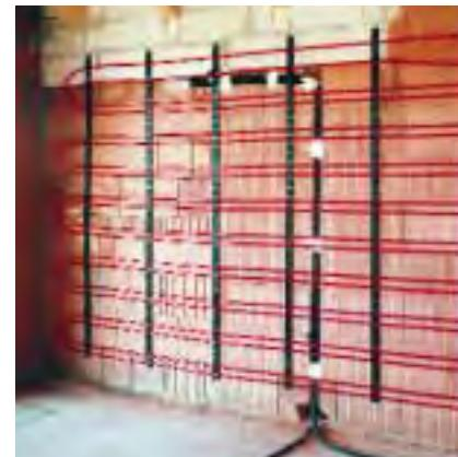
Στην υγρή τοποθέτηση οι θερμοσωλήνες RAUTHERM S κουμπώνονται στις ράγες RAUFIX που έχουν στερεωθεί επάνω στον τοίχο. Επι είναι δυνατή η απλή και γρήγορη υγρή τοποθέτηση χωρίς τη χρήση ειδικών εργαλείων.
