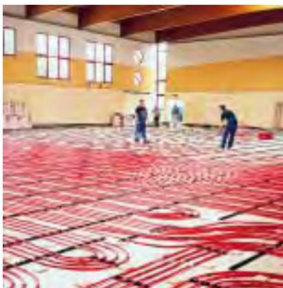
Η REHAU ανέπτυξε για τα αθλητικά και τα καρφωτά δάπεδα ένα σύστημα θέρμανσης που τοποθετείται γρήγορα και εύκολα όσο κανένα άλλο. Το σύστημα θέρμανσης καρφωτών δαπέδων της REHAU σχεδιάστηκε έτσι, ώστε να καλύπτονται οι απαιτήσεις του DIN 18032 T2, δηλ., δεν περιορίζει την κατασκευή του καρφωτού δαπέδου με κανέναν τρόπο. Επιπλέον, υπάρχει η δυνατότητα να διατηρηθεί ο τύπος στερέωσης των σωλήνων σε περίπτωση επισκευής του καρφωτού δαπέδου.
